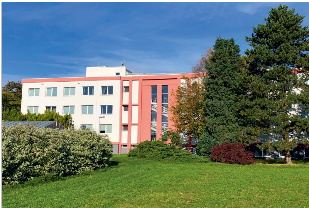
V minulém roce proběhla v hlavní budově náročná rekonstrukce, jejímž hlavním cílem byly úspory energií a obnova funkčních systémů stavby
